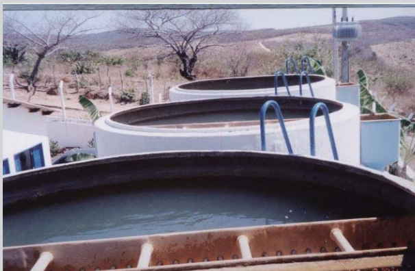
Figura 14 - Filtros de fluxo ascendente sem tampa
