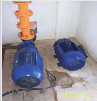
Figura 11 - Motor-bomba reserva
