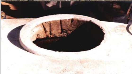
Figura 18 - Não-conformidades de segurança sanitária de reservatórios
