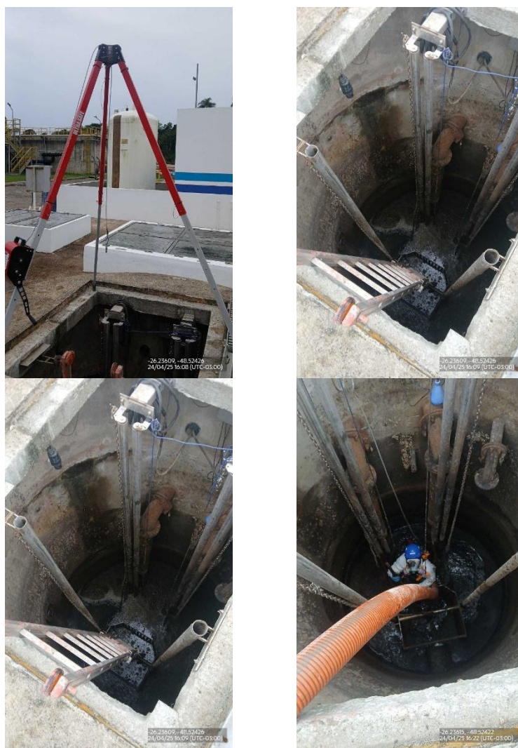
Figura 15: Limpeza Preventiva na Elevatória Interna da ETE Ubatuba
