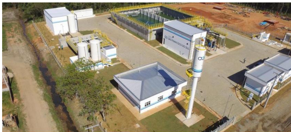
Figura 2 – Estação de Tratamento de Esgoto Ubatuba
