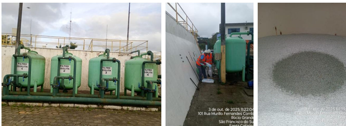
Figura 7: Limpeza e substituição do meio filtrante dos filtros pressurizados
