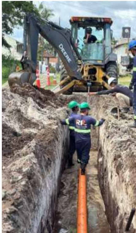
Figura 32 - Execução de rede coletora
