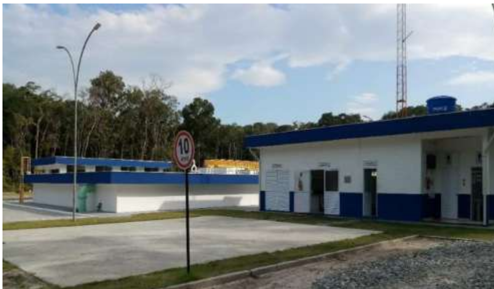
Figura 10 - Reservatório ETA Maria Catarinense
