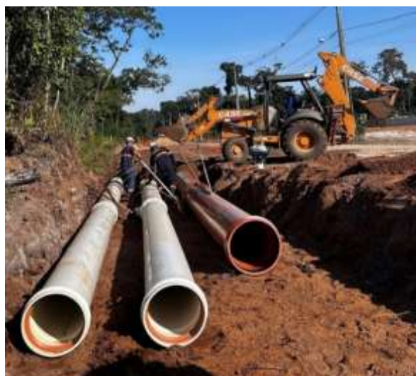
Figura 34 - Instalação da linha de emissário de efluente tratado
