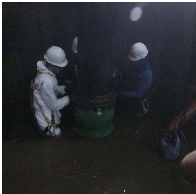
Figura 25 - Válvula pé de crivo reformada
