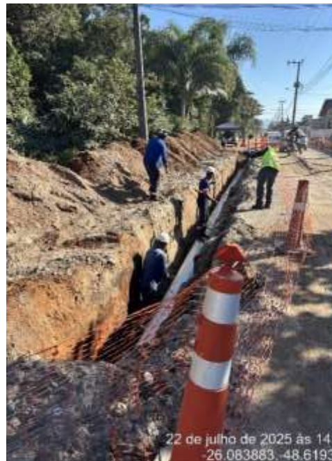
Figura 33 - Execução de rede coletora
