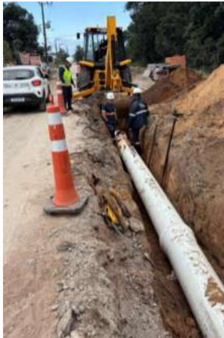
Figura 33 - Execução de rede coletora
