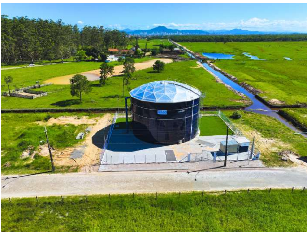
Figura 3. Novo reservatório do Gravatá
