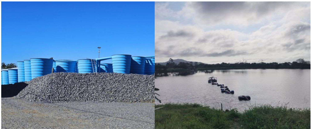
Figura 2. Lagos de captação e caixas de tratamento água bruta da ETA Pedreiras
