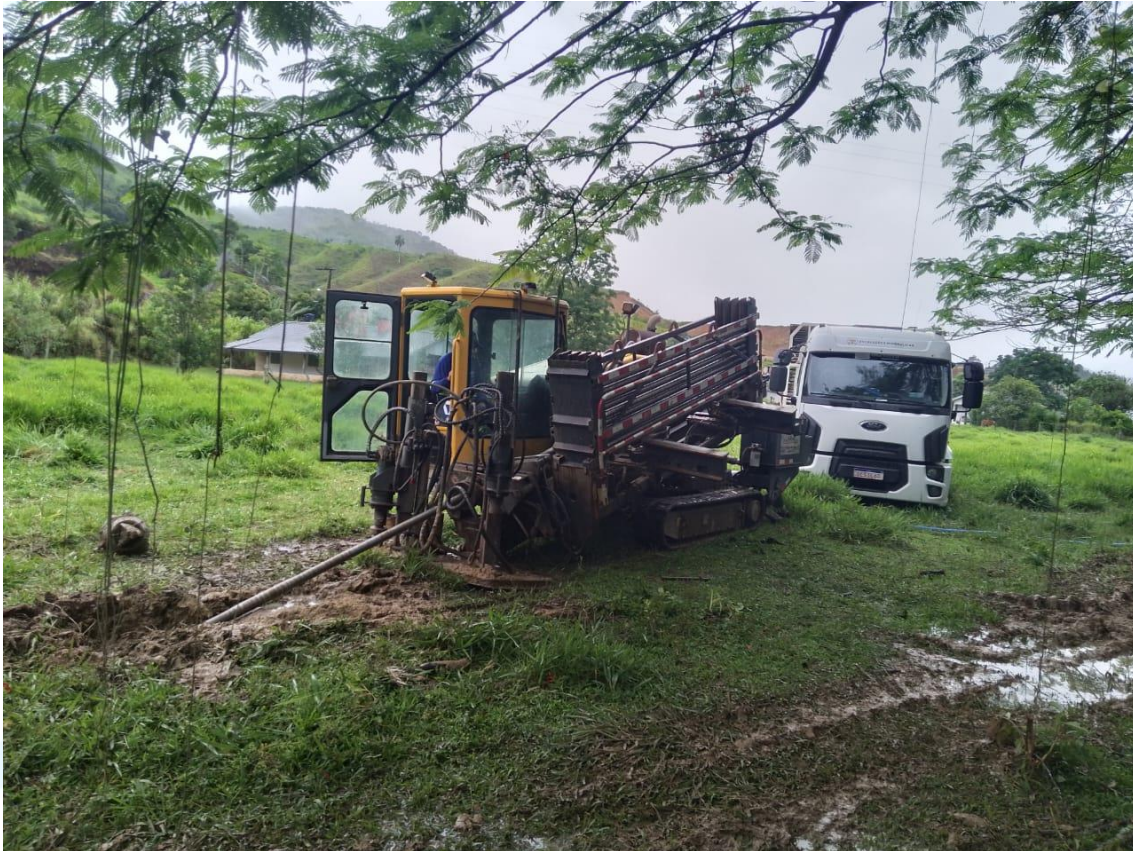
Figura 5 - Execução MND Bairro Termas do Gravatal.
