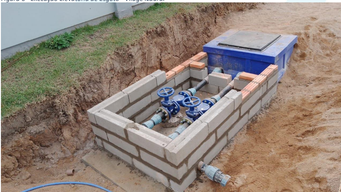
Figura 6 - Execução Elevatória de Esgoto - Vilage Izaura.
